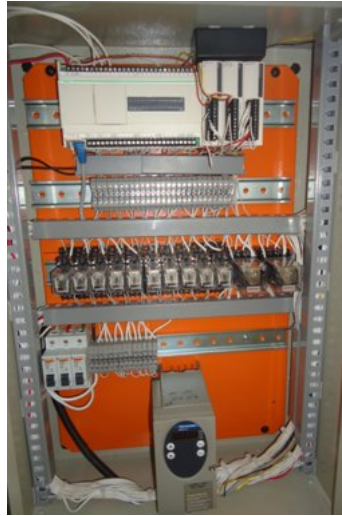
Figura 3.8: Tablero para la fijación de los elementos
