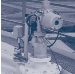
Figura 1.10: Medición directa de nivel mediante servo guiado
