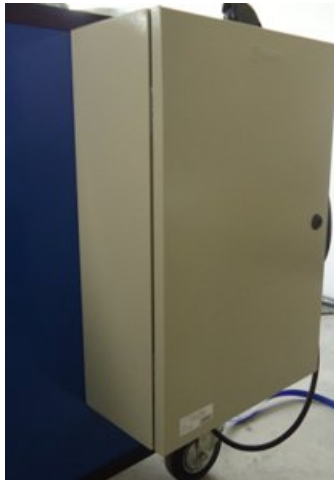
Figura 3.9: Fijación del tablero en la estructura del módulo
