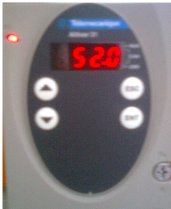
Figura 4.7: Valor de Frecuencia en el variador
