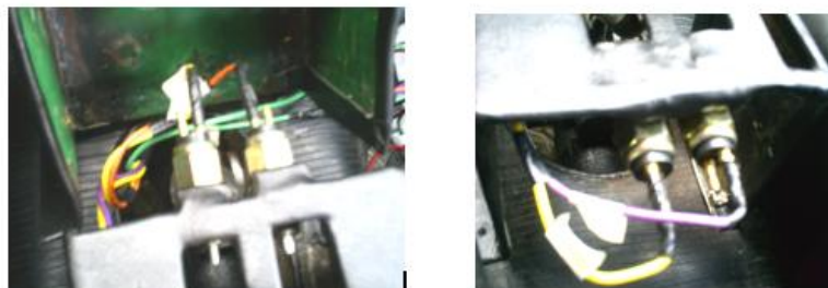
Figura 3.60. Implementación de cableado hacia los sensores de posición.
