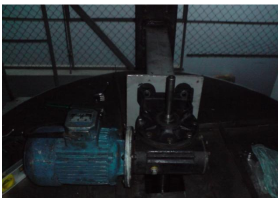
Figura 4.6 Montaje del Moto reductor
