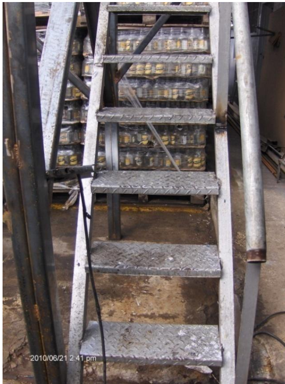
Figura 4.24 Colocación de gradas
