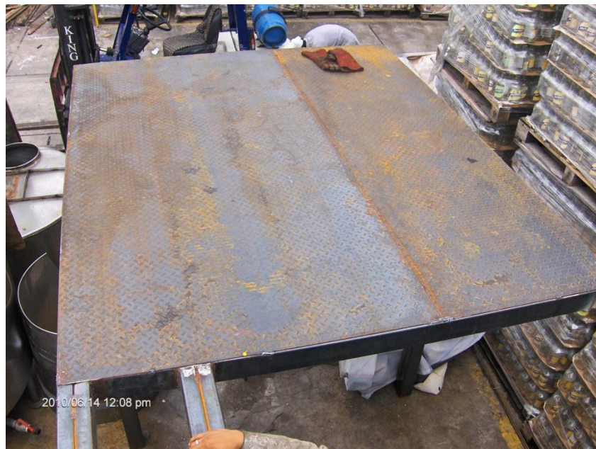
Figura 4.23 Colocación del piso
