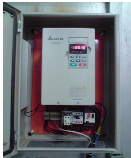
Figura 4.29 Montaje del variador de frecuencia y sus protecciones
