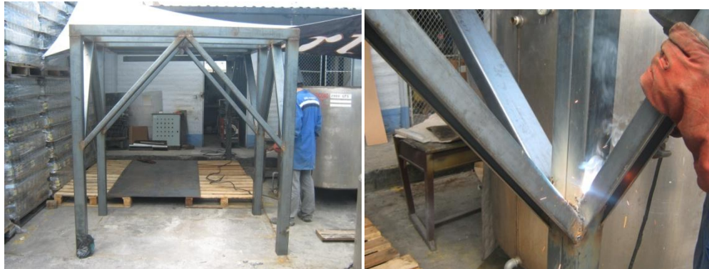
Figura 4.22 Colocación de correas simples al armazón
