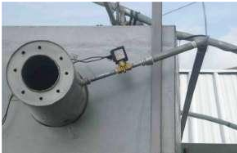
Figura 3.2 Sistema de distribución de CO 2 .
