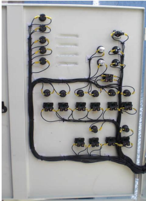
c) Cableado de botoneras y luces piloto
