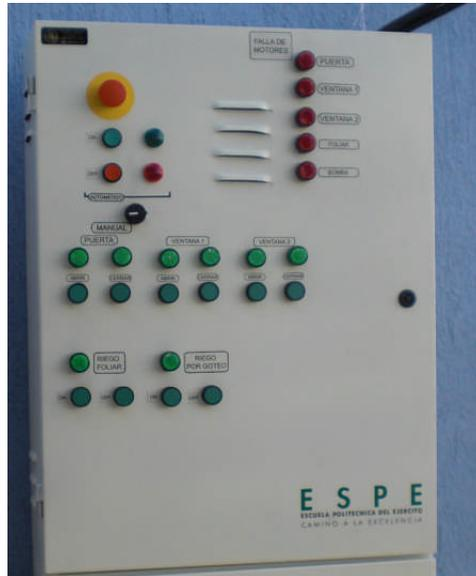
**Figura 3.5 Dispositivos de mando y señalización**
