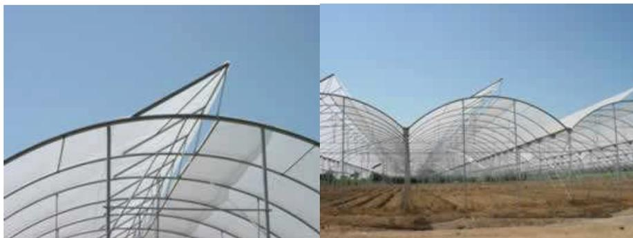
**Figura 2.2 invernadero techumbre curva con ventilación cenital**
