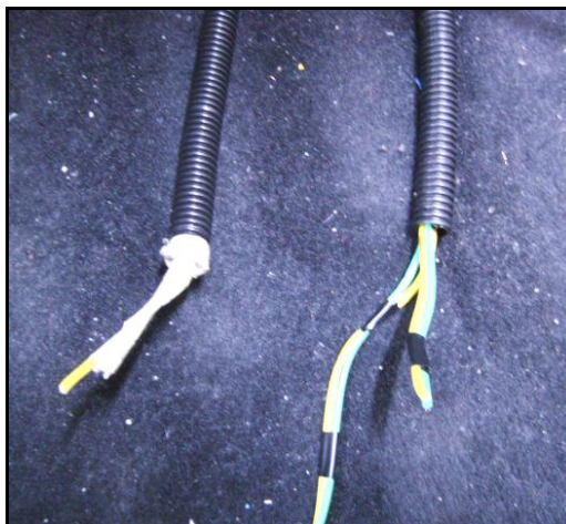
Figura 3.67 Mangueras portadoras de cables que llegan hacia el modulo inmovilizador
