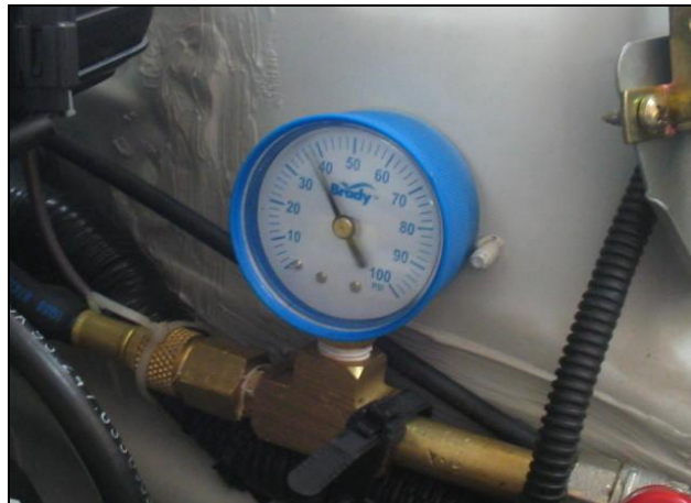
Figura 3.10. Punto de control de presión.
