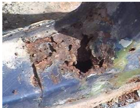
Gráfico 48 (Estribo y montante oxidados)
