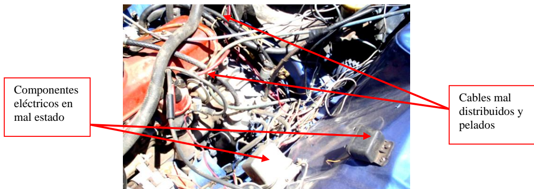
Gráfico 122 (Apreciación del sistema eléctrico deteriorado)
