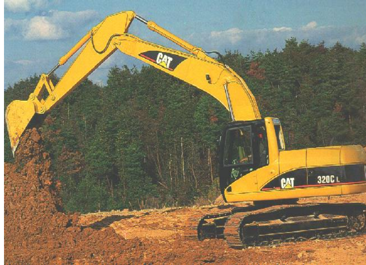
Figura-1.1 Retroexcavadora realizando un trabajo.
