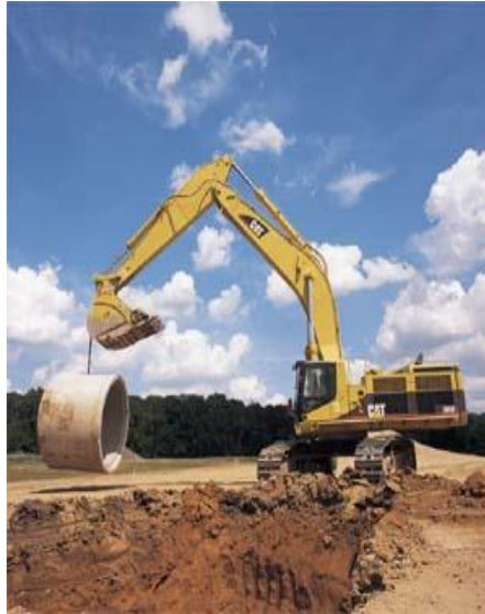
Figura. 1.2 Retroexcavadora levantando tubos
