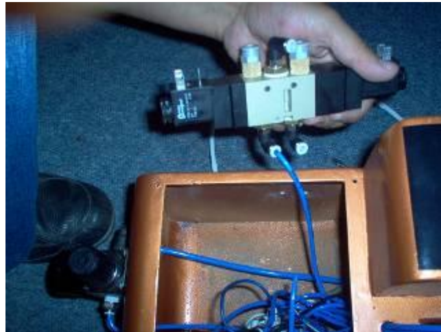
Figura. 3.12 Colocación de las electroválvulas
