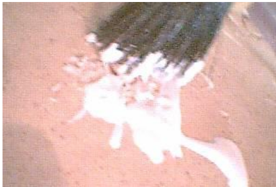
Fig. 4.6 Colocación de pegamento
