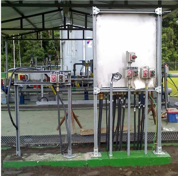
a) Soporte para la caja de conexiones.
