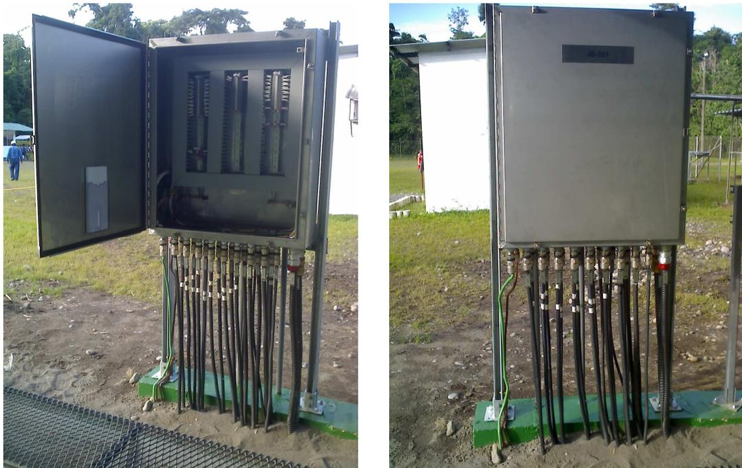
**Figura 3.2. Caja de conexiones (JB).**
