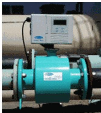
**Figura 1.28. Fluxómetro electromagnético.**
