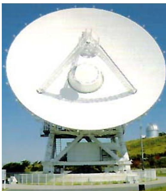
Figura 2.41. Antena Cassegrain
