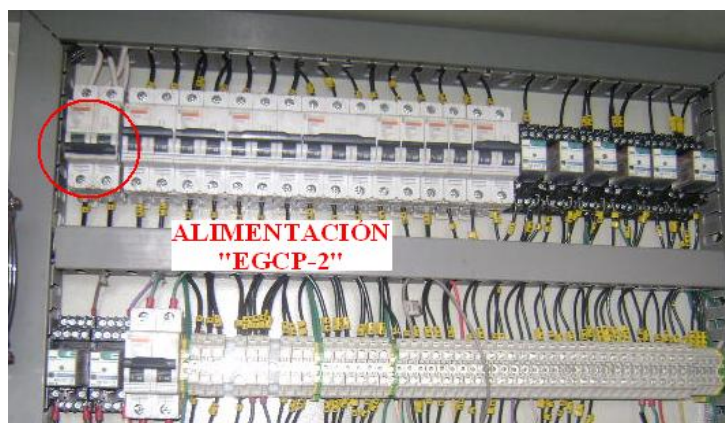
Figura N° 4.2 Breaker de alimentación EGCP-2
