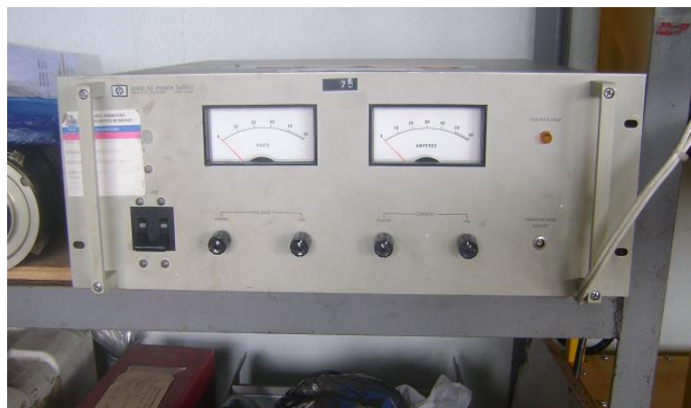
Fig. 4.2 Fuente variable DC, que alimenta el motor del sistema
