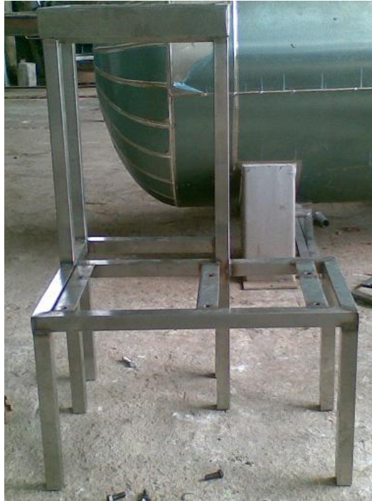
Figura 3.2 Construcción de estructura base en Acero AISI 304
