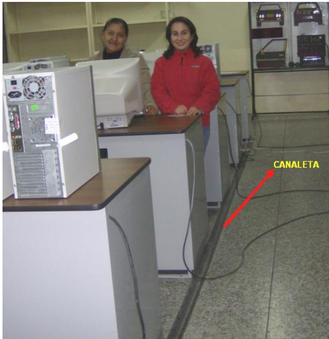
Figura 5.60. Tendido y aseguramiento de los cables de la red
