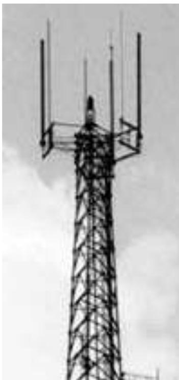
**Figura 3.10** Antenas Omnidireccionales RFS para Sistemas de Radio Móvil [3.22]
