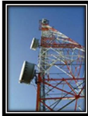
Figura Nº 1.5 Microondas Terrestre
