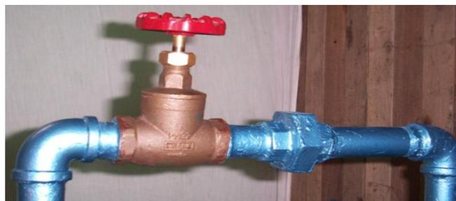
Figura 4.7 Acople de la válvula limitadora de presión
