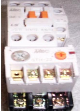
**Figura 4.12 Vista Frontal de un Relé Térmico**
