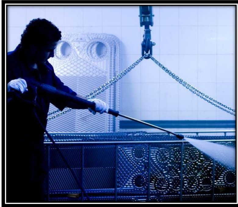
Figura 2.43 Mantenimiento a un intercambiador de calor
