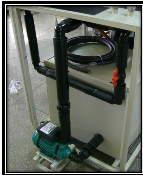
Figura 5.10 Instalación de tuberías en el sistema de calentamiento
