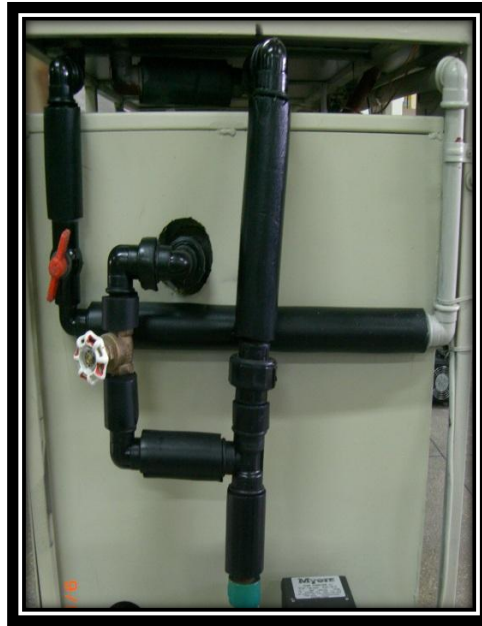
Figura 5.9 Instalación de tuberías en el sistema de refrigeración
