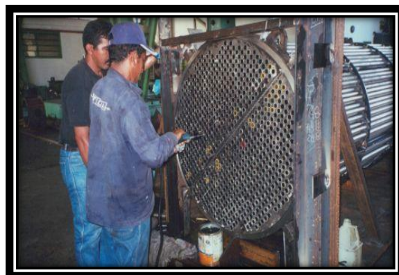
Figura 2.44 Mantenimiento a un intercambiador de calor multitubo
