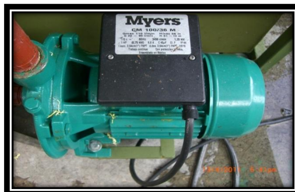
Figura 2.67 Bomba para distribuir agua
