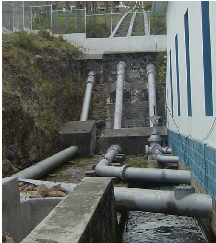
Los tubos se forman arrollando chapas rectangulares de palastro, a las que se da forma cilíndrica uniendo longitudinalmente los bordes de estas chapas.
