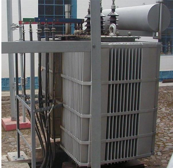
Bajo la denominación general de transformador se le designa como un dispositivo estático, es decir sin partes móviles, destinado a transferir energía eléctrica de un circuito a otro siendo el enlace un flujo magnético común.
