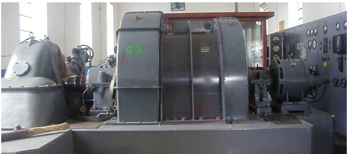
La casa de máquinas consiste del edificio principal de un desarrollo hidroeléctrico, en donde tiene lugar la conversión de la energía del agua, en energía eléctrica.
