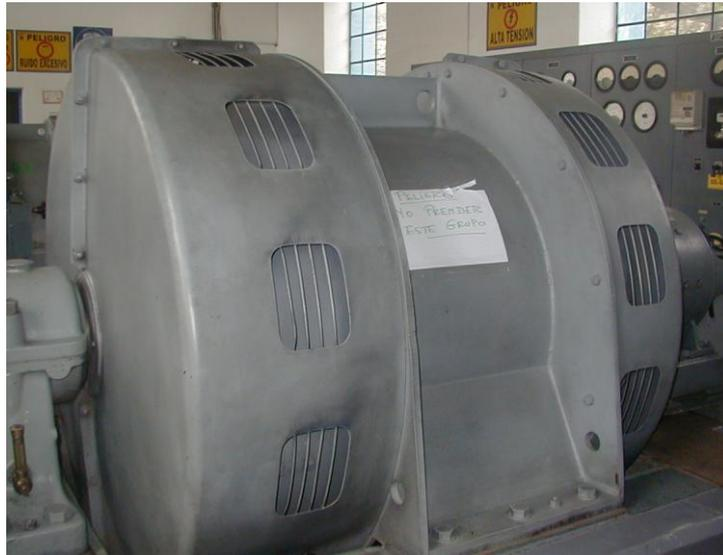
El generador transforma la energía mecánica en energía eléctrica. Está acoplado mecánicamente al eje de la turbina, bien por acople directo o a través de una transmisión que por lo general es elevadora.
