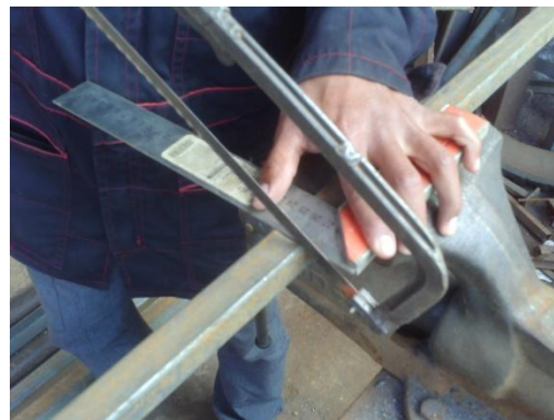
Foto N-º 2.2 Corte del tubo
