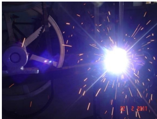
Foto N-º 2.4 Soldadura de tubos
