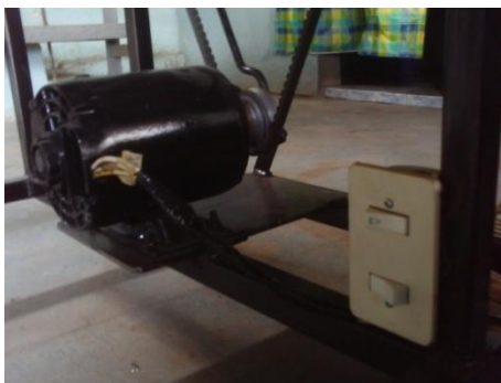
Foto N-º 4.2 Montaje del motor eléctrico con polea
