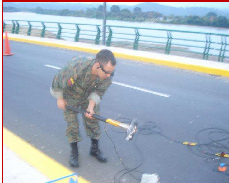
Figura 4.11 Golpe de martillo para realizar el Ensayo
