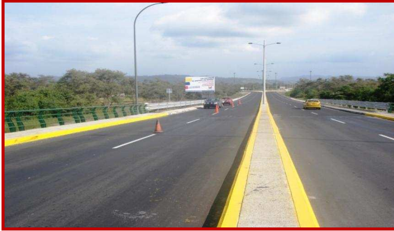
Figura 4.13 Puente Norte de Esmeraldas
