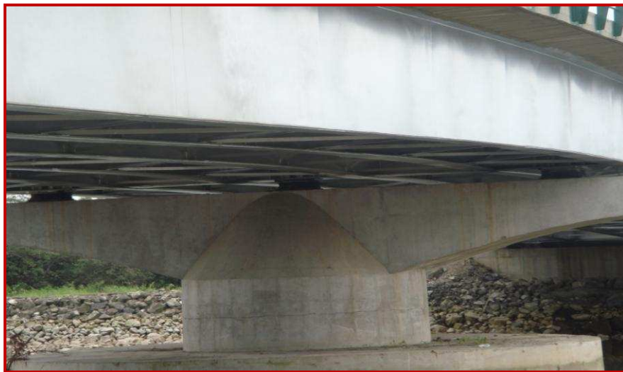
Figura 5.11 Aisladores bajo el Puente Norte.
