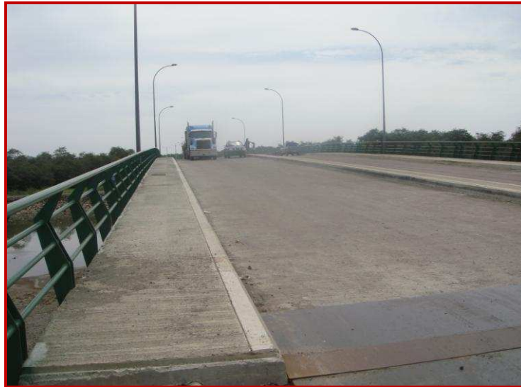
Figura 5.13 Puente Norte Soportando cargas dinámicas.
