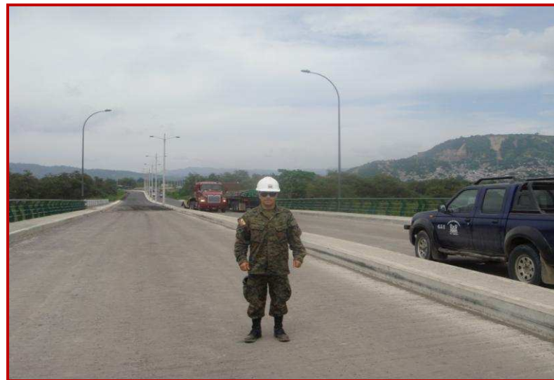
Figura 4.12 Puente Norte de Esmeraldas
