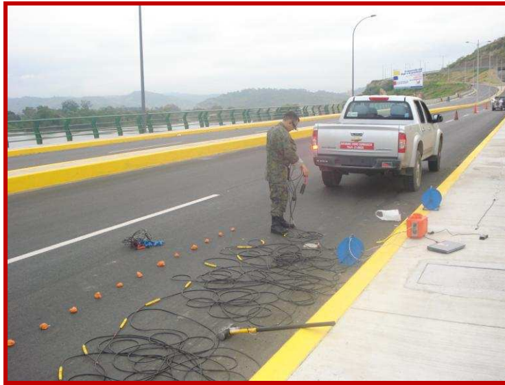
Figura 4.21 Ensayo de campo de sismica de reflacción con su material
