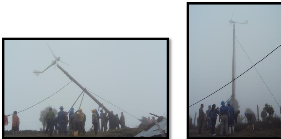
Figura 3.7: Colocación manual del poste y aerogenerador en el sitio elegido
