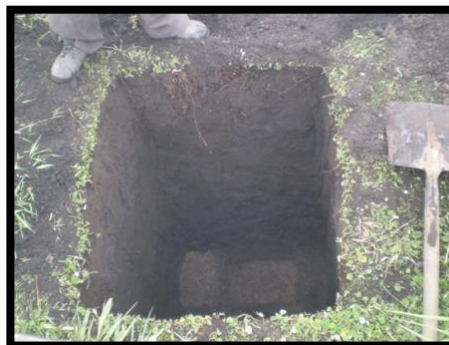
Figura 3.3: Hoyo listo para la colocación del poste
