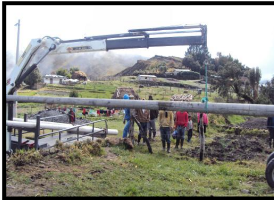
Figura 3.4: Traslado del poste cerca al lugar elegido para su colocación
