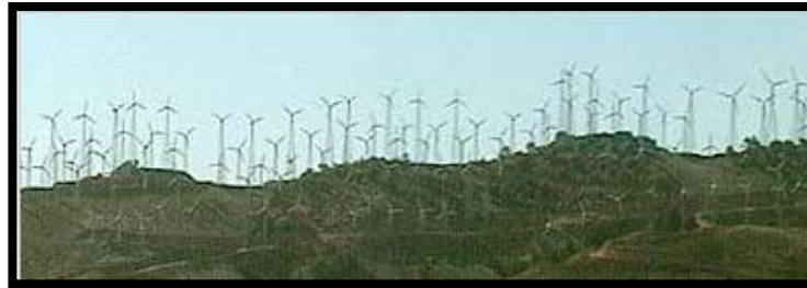
Figura 1.18: Parque eólico en Tehachapi Pass, California. Fuente: http://erenovable.com/2010/06/14/energia-eolica-2010/
