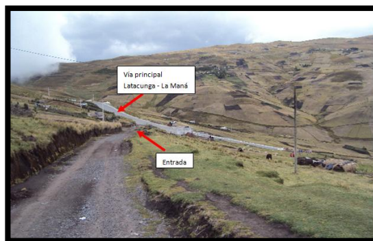
Figura 1.1: Carretera de ingreso a la comunidad Corralpungo
