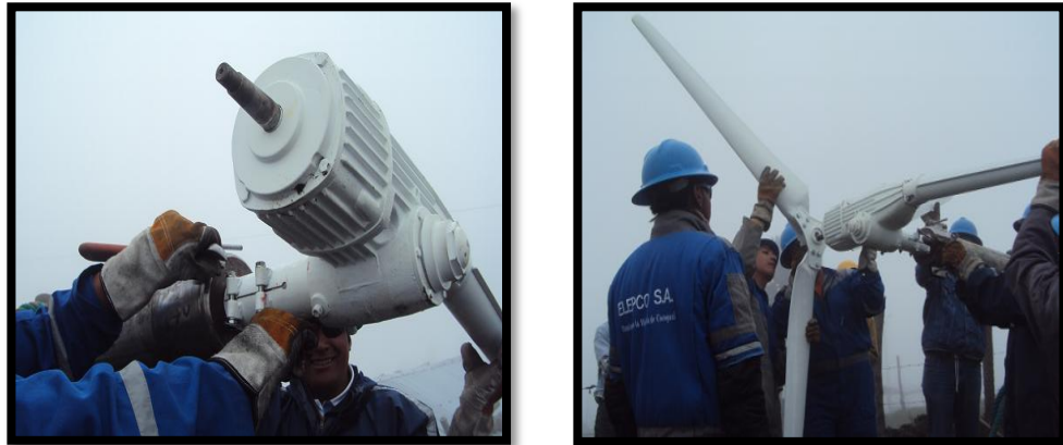
Figura 3.6: Montaje del aerogenerador en la parte superior del poste
