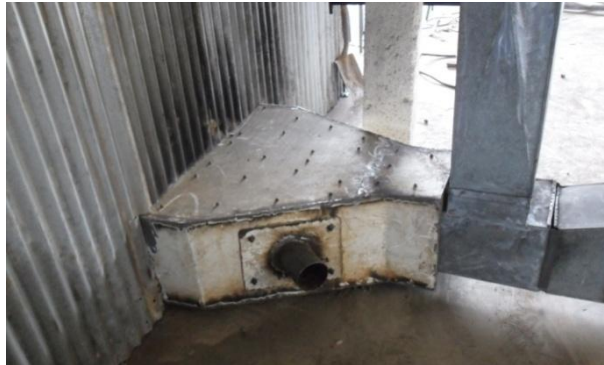
Figura 3.30: Montaje de la cámara de combustión.
