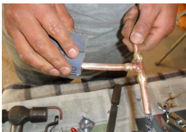
Figura 3.25: Limpieza del tubo de Cobre.
