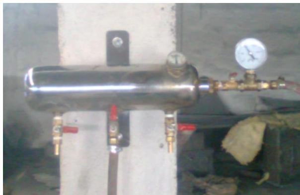
Figura 3.26: Instalación del sistema de Alimentación.
