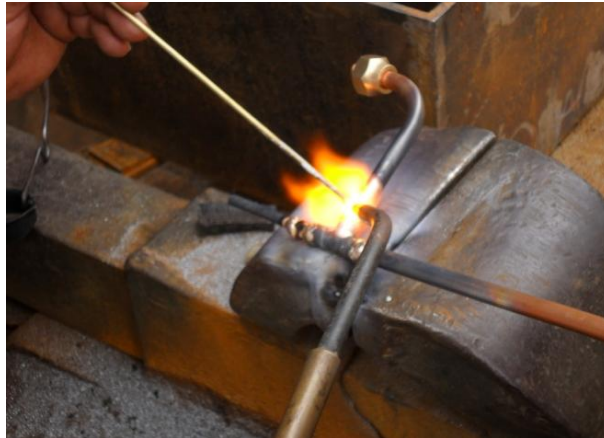
Figura 3.24: Proceso de Soldadura del tubo de Cobre.
