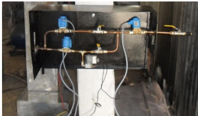
Figura 3.34: Montaje del sistema de Distribución del GLP.
