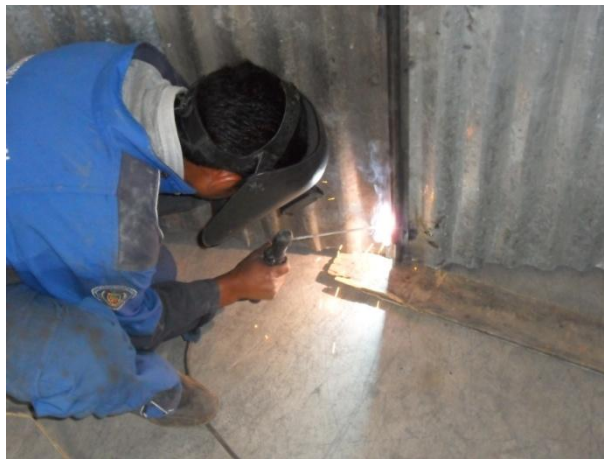
Figura 3.11: Proceso de Soldadura con arco Eléctrico.
