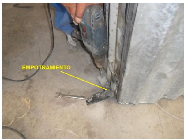
Figura 3.29: Empotramiento del horno al piso.
