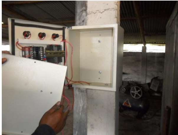
Figura 3.35: Montaje del Tablero de Control.
