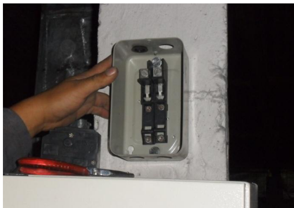
Figura 3.28: Instalación del Tablero de Protección.
