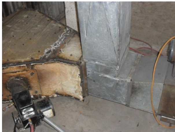
Figura 3.32: Montaje de los Ductos.
