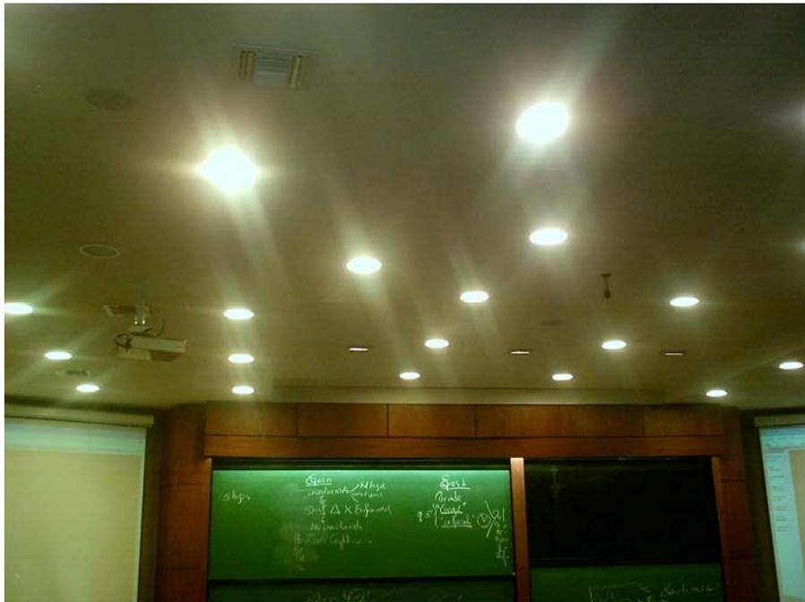
**Figura 5.31. Sistema de Iluminación y Audio Instalado en el techo del Aula**
