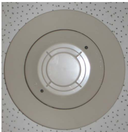
Figura 6.22.- Foto sensor Térmico
