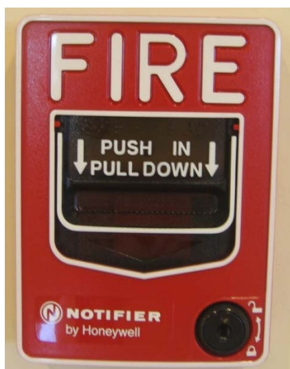
Figura 6.23.- Foto Estación Manual
