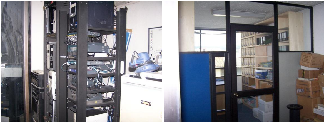
Figura 3.8 Cuarto de equipos y bodega
