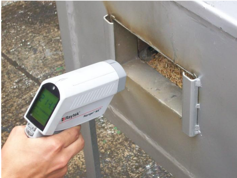
Figura 6.5. Medición de temperaturas utilizando sensor láser.
