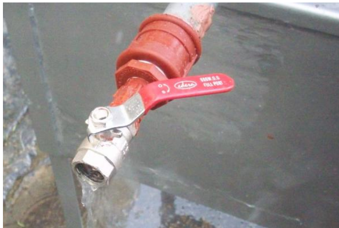
Figura 2 Caudal a la salida del intercambiador.
