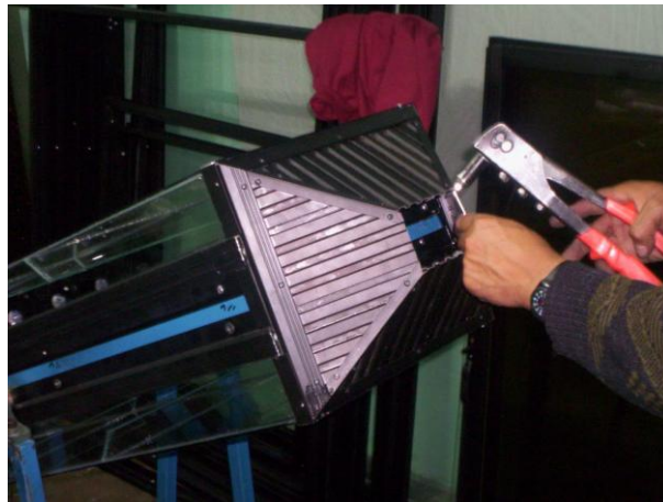
Figura 4.14. Implementación del ducto de salida de aire
