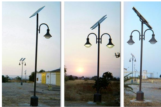
Figura 2.18 Farolas Fotovoltaicas
