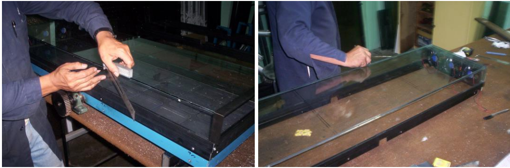
Figura 4.7. Construcción de los alerones de direccionamiento de aire
