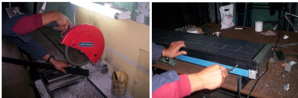
Figura 4.2. Construcción del marco estructural de aluminio apoya-coraza
