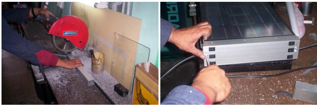
Figura 4.1. Construcción de la unidad de control eléctrico
