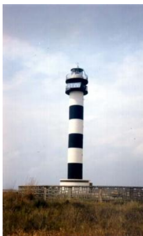
Figura 2.27 Faro Accionado con Paneles Fotovoltaicos
