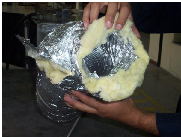
Figura 4.16. Colocación de lana de vidrio alrededor del ducto de aluminio
