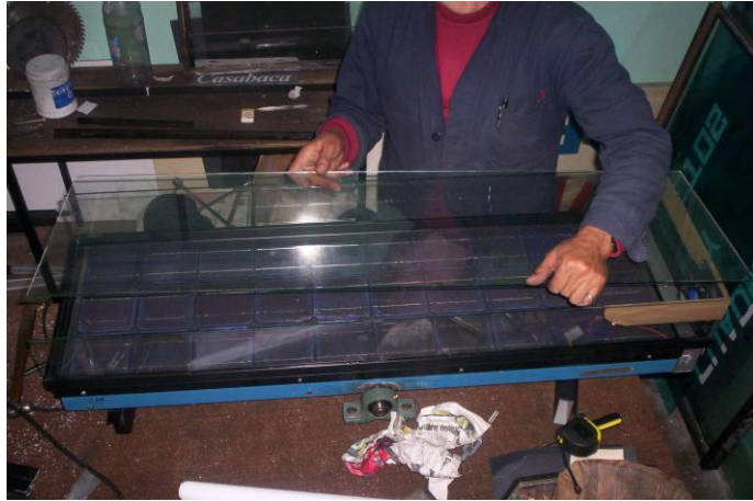
Figura 4.3. Construcción y armado de corazas superior e inferior
