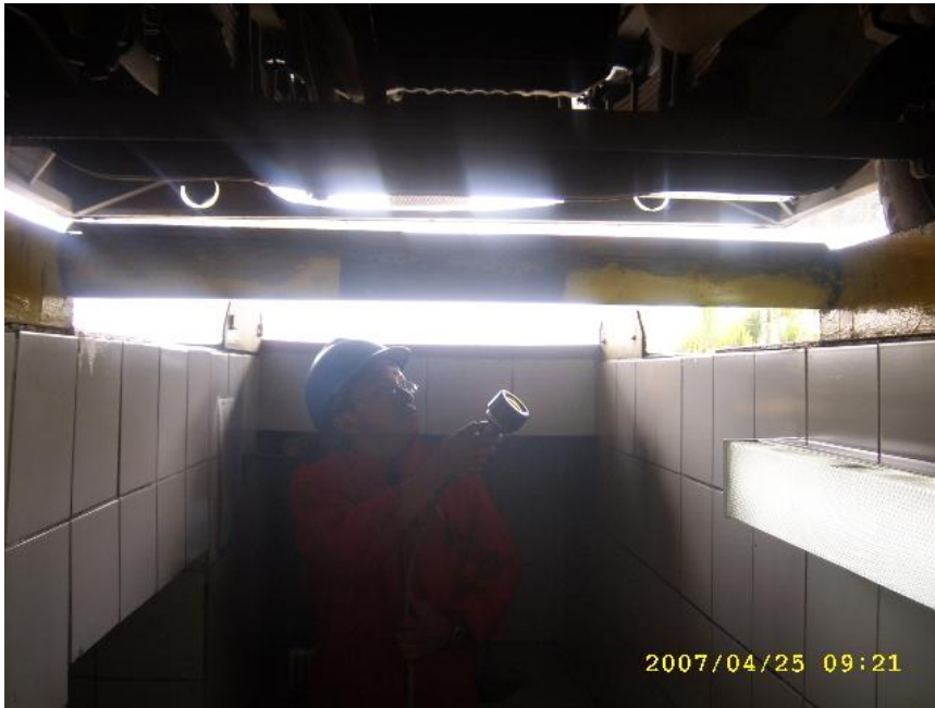
Fotografía 16 Inspección de holguras en el foso de inspección
