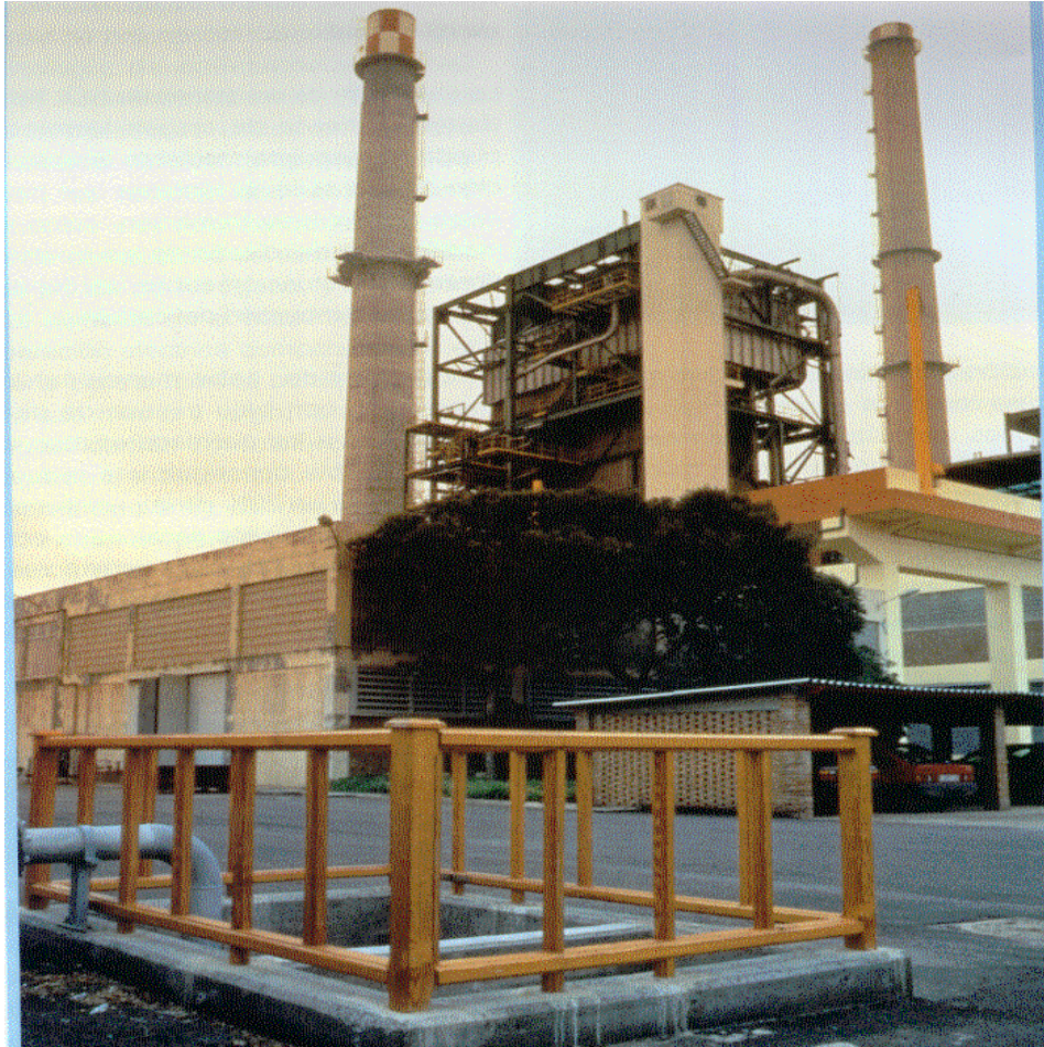
Figura 3.1 Pozo de recogida de aguas en la central térmica
