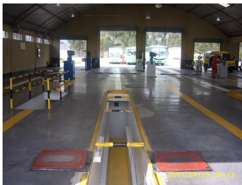
Fotografía 15 Foso de Inspección y detector de holguras
