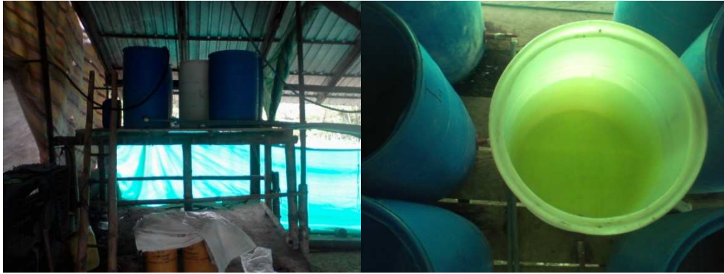
i. Instalación de tanques de agua para bebida
