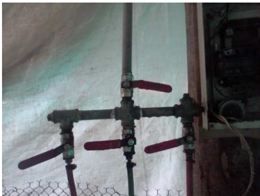
d. Instalación de tuberías de gas divisiones
