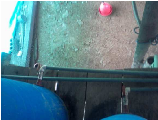
b. Instalación de red de tuberías
