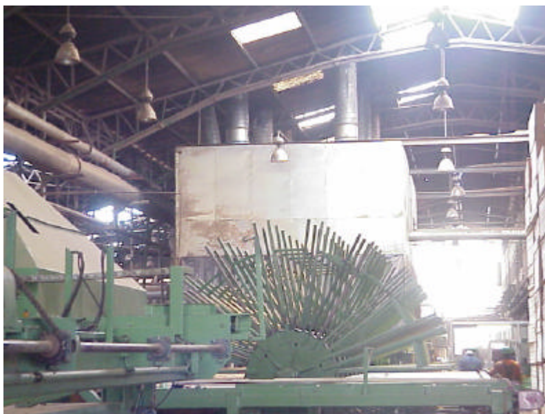
Figura. 2.4. Etapa de enfriamiento y sierra de separación
