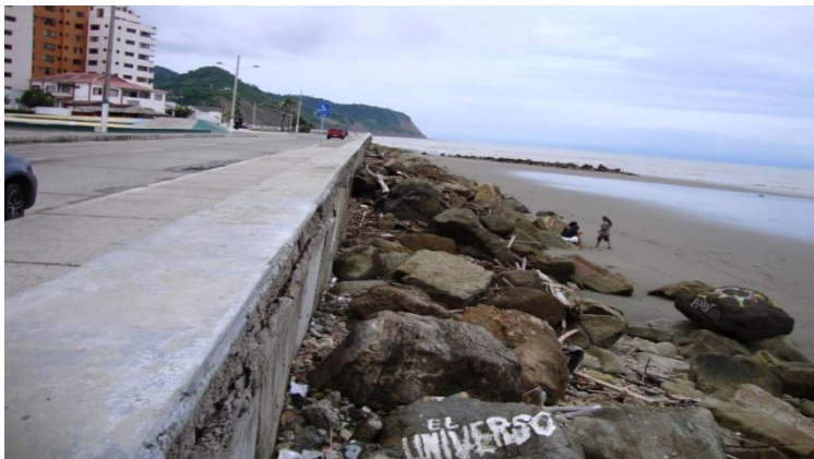
Fotografía 6. Muro de protección.
