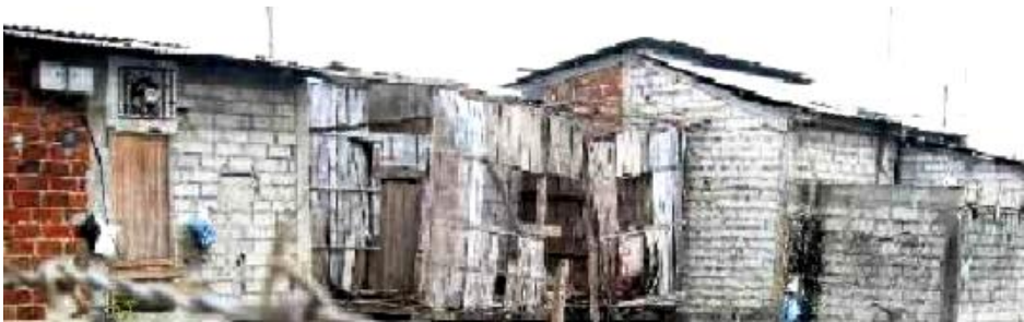
Fotografía 2. Construcciones mixtas y vetustas en la zona de alta vulnerabilidad.
