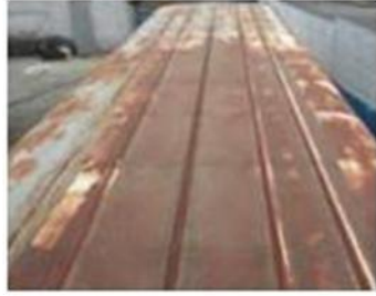
Gráfico No 5: Techo Oxidado y Estado de la Claraboya
