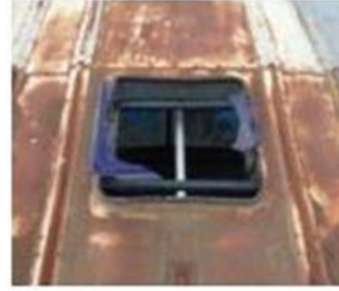
Gráfico No 5: Techo Oxidado y Estado de la Claraboya
