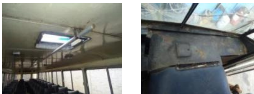
Gráfico No 10: Techo, laterales y cabina oxidados
