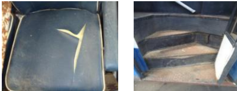
Gráfico No 8: Tapizado de asientos rotos y piso oxidado
