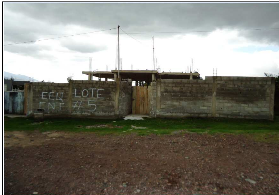
FIG. 2.7.1.5: Fotografía Servicio Eléctrico EEQ.
