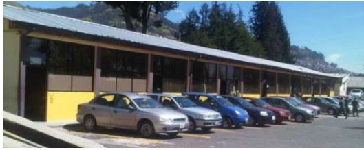
Figura 3.9 Aulas Sector Norte
