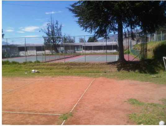
Figura 3.54 Canchas de Tenis
