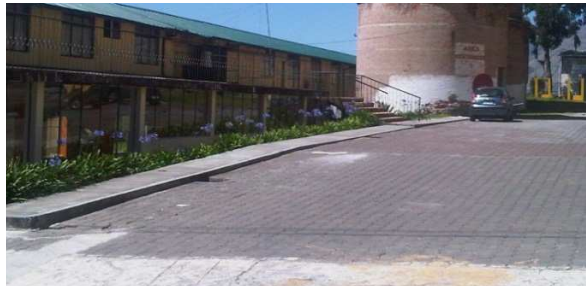
Figura 3.39 Estacionamiento Dormitorio de Oficiales
