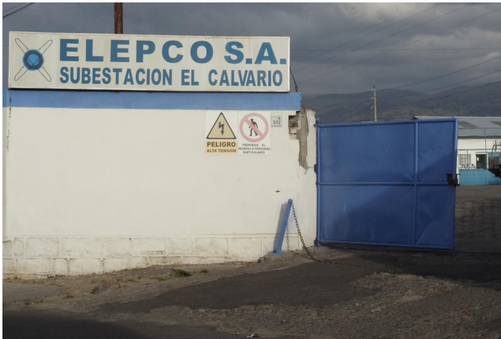
Figura 1-4 Vista frontal de la subestación El Calvario
