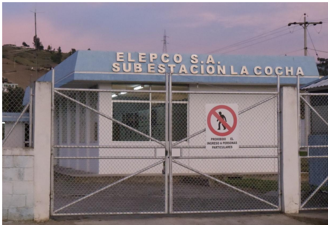
Figura 1-2 Vista frontal de la subestación La Cocha
