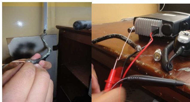
Figura. 3.15. Mantenimiento de la conexión conector PL 259- cable Belden
