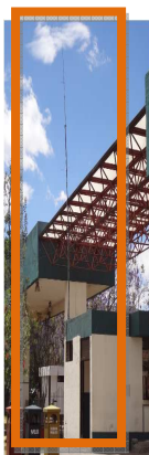
Figura. 2.33. Antena Omnidireccional ubicada en la Prevención de la ESPE Matriz
