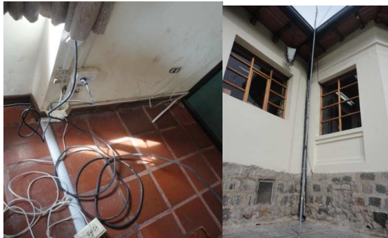
Figura. 3.19. Mantenimiento bajada de antena
