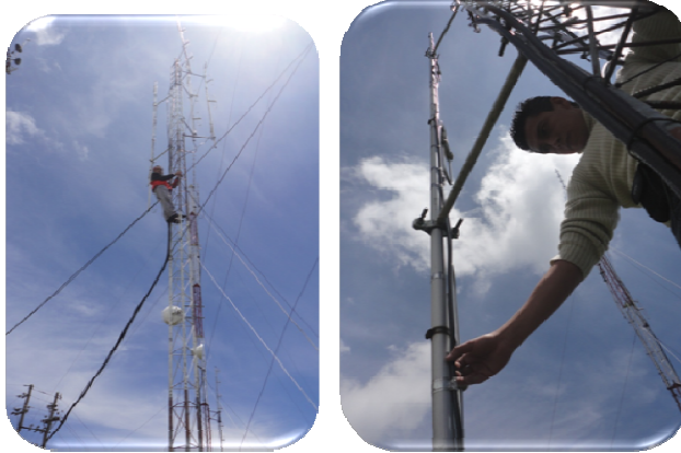
Figura. 3.5. Conexión antena Figura.3.6. Mantenimiento cinta auto fundente
