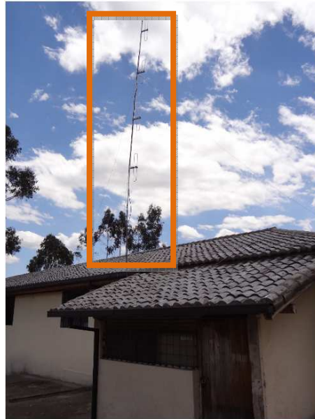
Figura. 2.34. Antena Omnidireccional ubicada en la Prevención del IASA I
