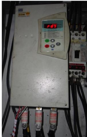
**Figura 3.15: Arrancador suave (motor del sistema hidráulico)**
