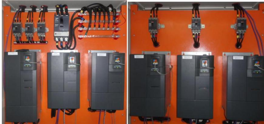
**Figura 3.13: Variadores de frecuencia (control motores camino de rodillos central y transferidor sur)**
