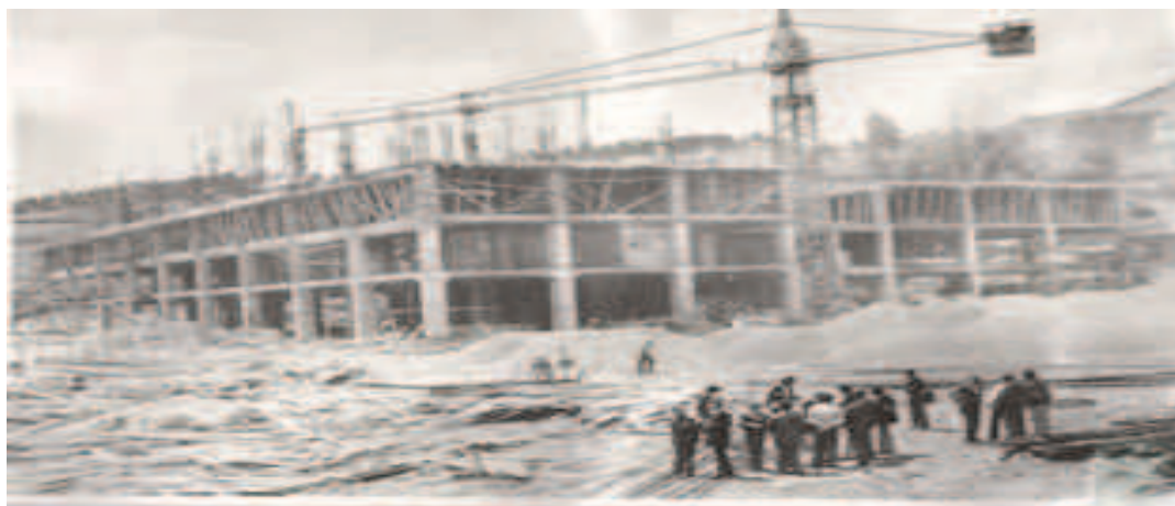
Gráfico. 1-2 Construcción del Hospital Enrique Garcés
