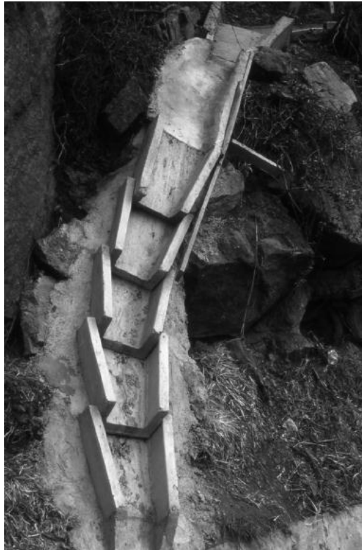
Fotografía 2.11: Torrentera de elementos prefabricados
