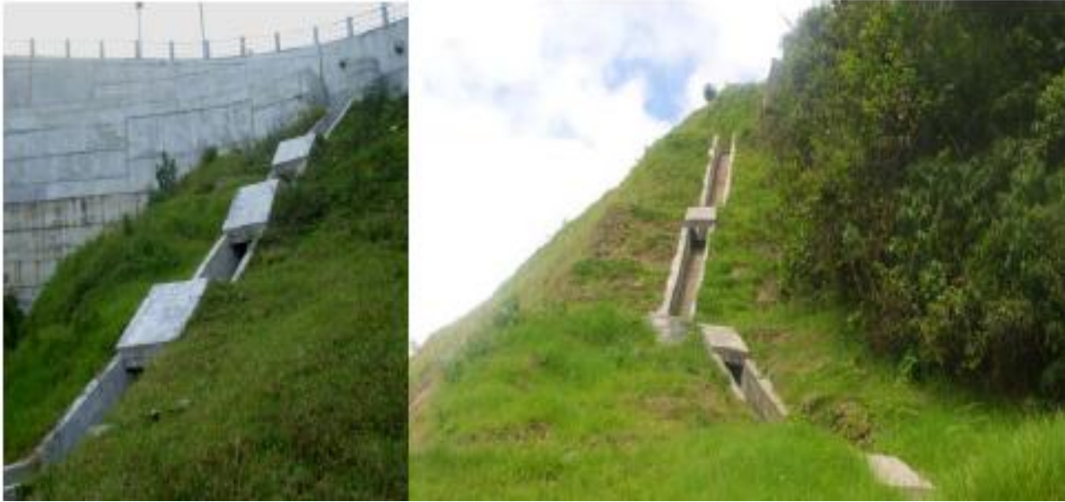
Fotografía 3.2: Canal de Rápidas con Tapa y Columpio (CRTC).
