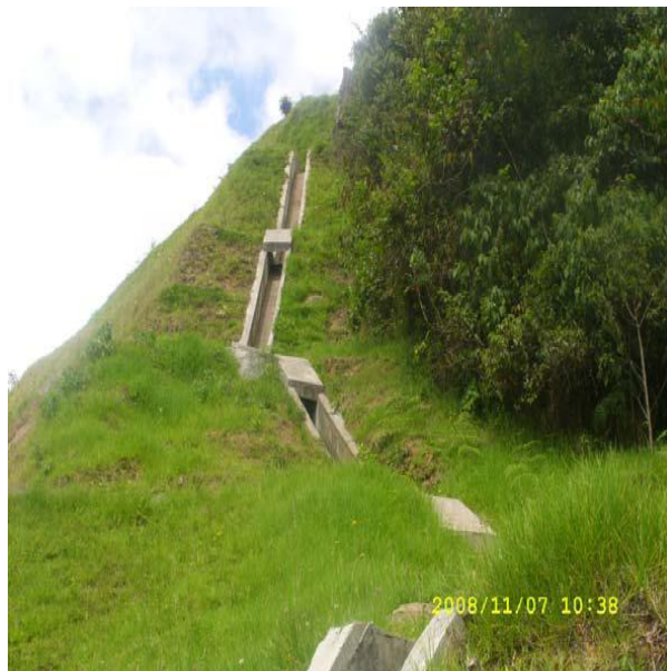
Fotografía 2.9: Canal de Rápidas con Tapa y Columpio (CRTC). Vista B.
