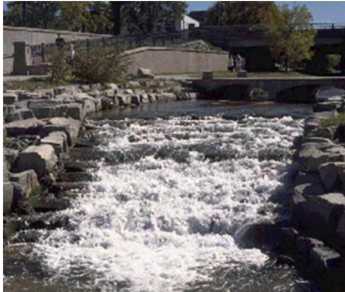
Fotografía 2.20: Caída inclinada
