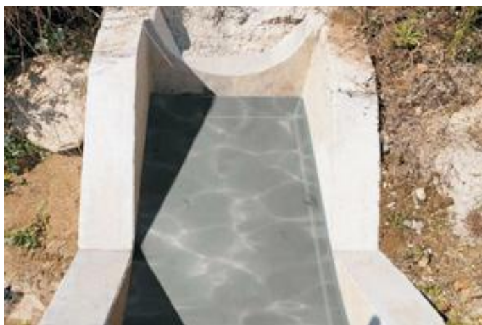
Fotografía 2.13: Rampa de concreto simple. Vista A.
