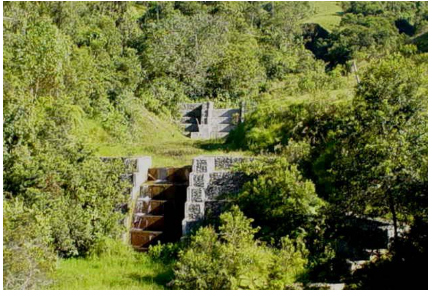
Fotografía 2.12: Disipadores de energía artificiales. Diques escalonados construidos en Quebrada El Silencio. Manizales - Caldas, Colombia.
