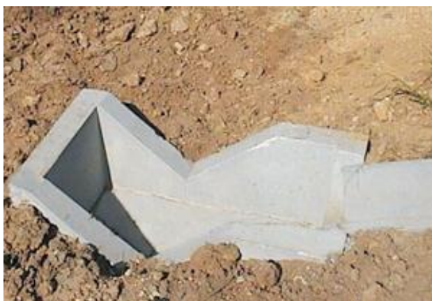
Fotografía 2.14: Rampa de concreto simple. Vista B.
