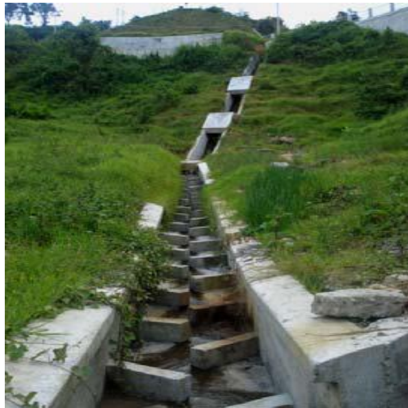
Fotografía 2.10: Combinación de CRTC y CPD.
