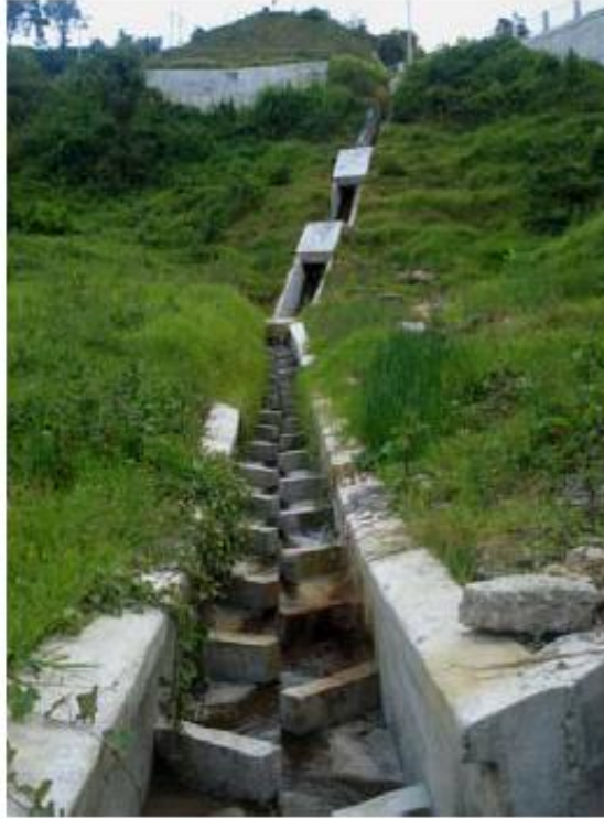
Fotografía 3.3: Combinación de CRTC y CPD.
