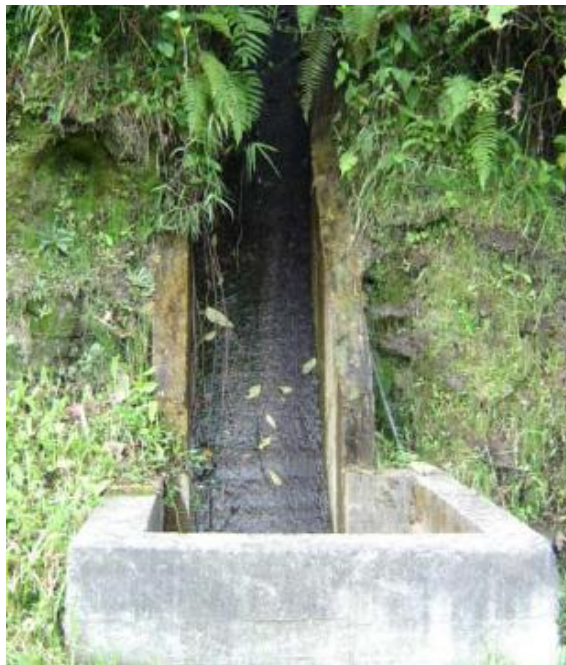
Fotografía 2.4: Canal de rápidas lisas.
