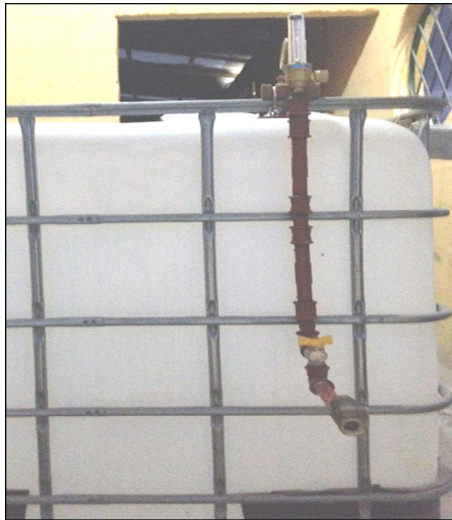
Figura 2.7 Vista lateral izquierda del inicio y construcción del biodigestor.
