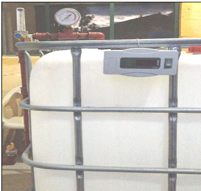
Figura 2.8 Ubicación de la termocupla en la construcción de biodigestor.
