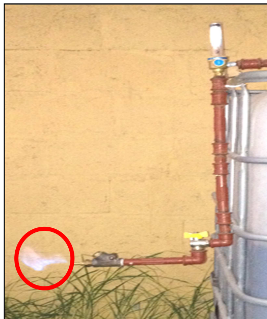
Figura 3.14 Encendido del Biogas.
