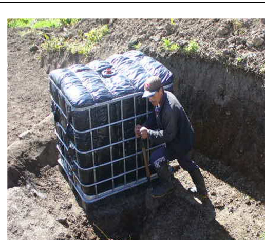
Figura 3.5. Fotografías de la instalación del digestor en la Finca. Mayo 2012. Elaborado por: (Autor).
