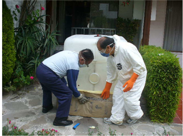
Figura 3.4. Fotografía del tanque digestor con el forro de lana de vidrio. Mayo.2012. Elaborado por: (Autor).
