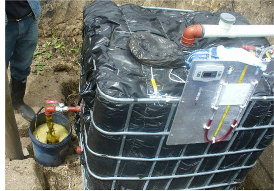
Figura 3.10. Fotografía de descarga regular en el digestor. Julio 2012. (Elaborado por (Autor)).
