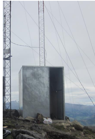
Figura 7: Shelter de Telecomunicaciones [A]
