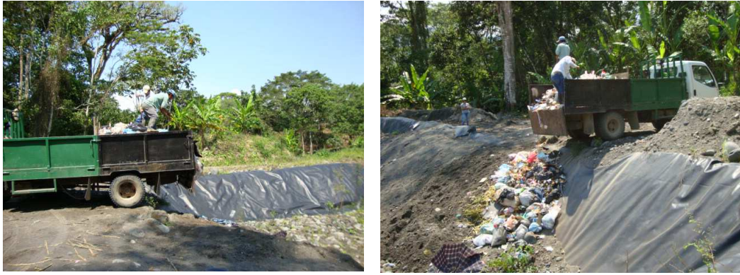
Figura 29. Descarga manual de residuos sólidos en la plataforma.
