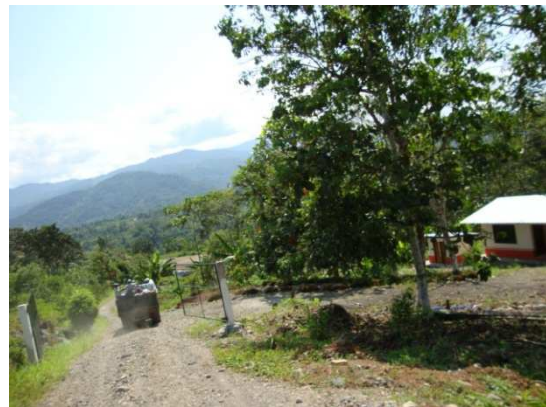
Vía de ingreso al Relleno Sanitario
