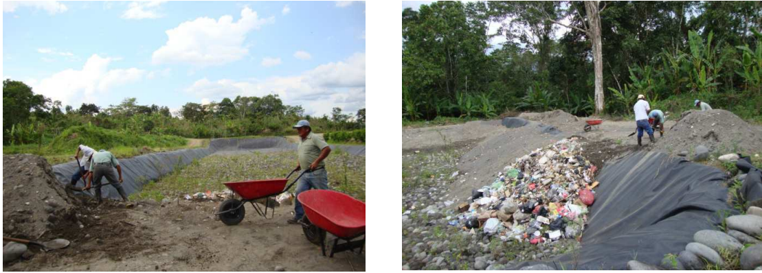
Figura 30. Tendido manual y colocación de material de cobertura.
