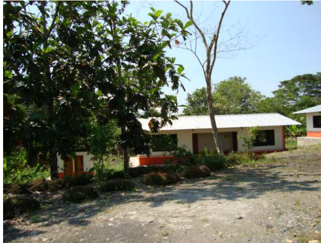
Figura 21. Infraestructura para oficinas, bodega y baterías sanitarias.
