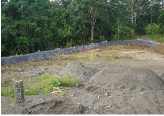
Figura 36 Instalación de chimeneas de drenaje de biogás.
