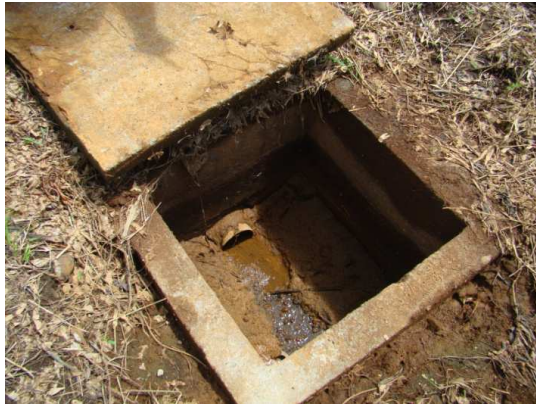
Figura 38. Caja de recolección de lixiviados provenientes de las plataformas 1 y 2
