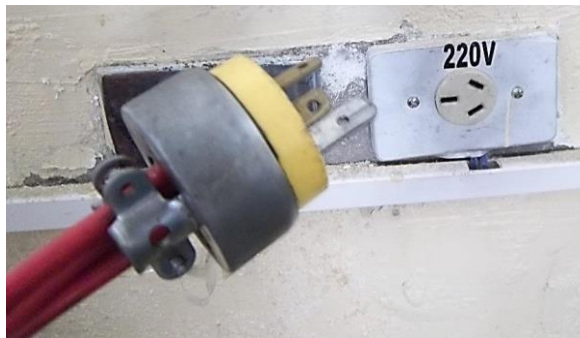
Figura 5.5: Conexión del compresor a la fuente
