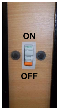
Figura 4.2: Componentes montados en el tablero de control (Vista lateral)
