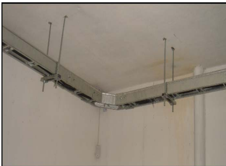
Figura 5.6. Electro-canales Metálicos.
