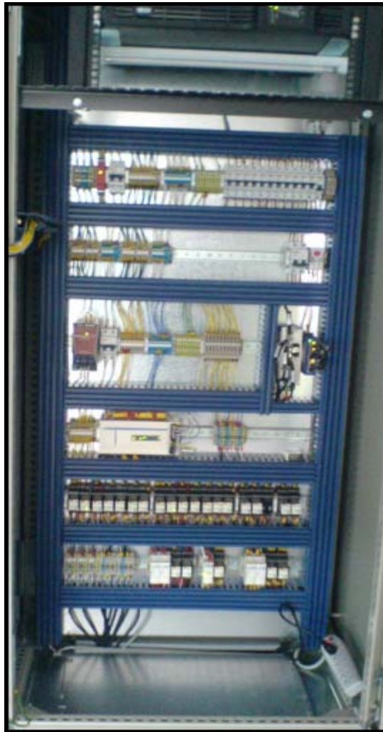
Figura 5.20. Distribución de los elementos eléctricos instalados.
