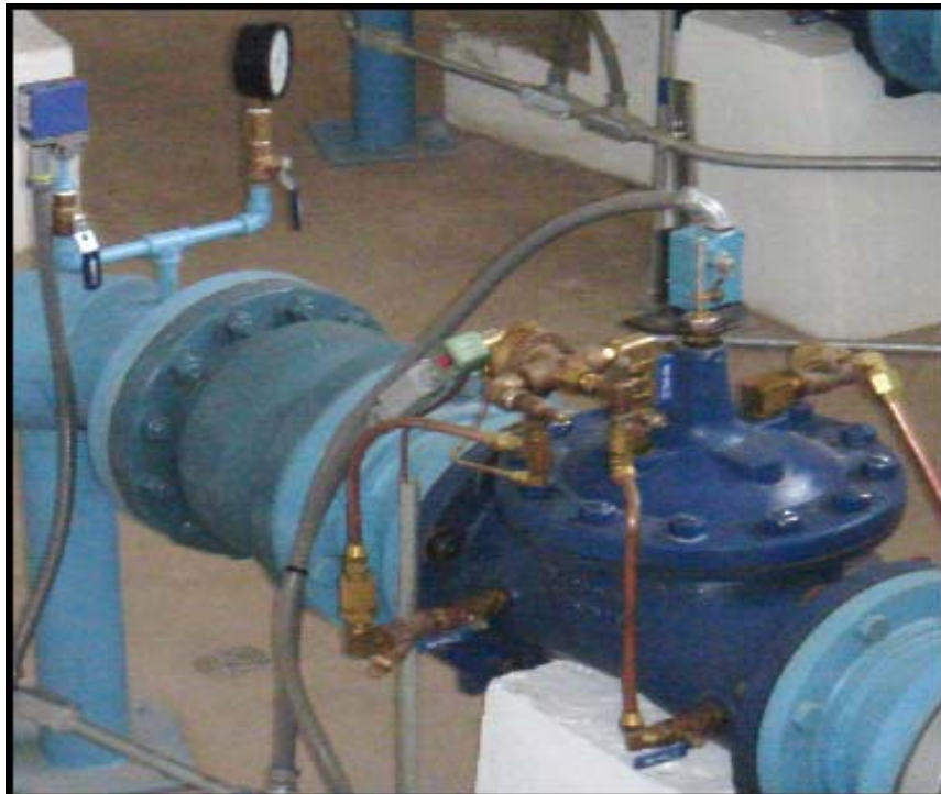
Figura 5.13. Electroválvula y Presostato.
