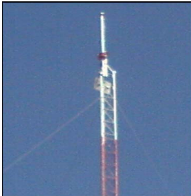
Figura 5.24. Torre de comunicaciones
