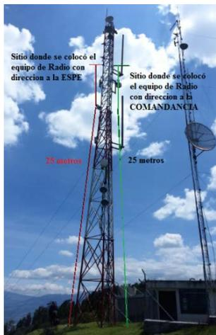
**Figura. 7. Montaje de los equipos de radio en Miravalle**
