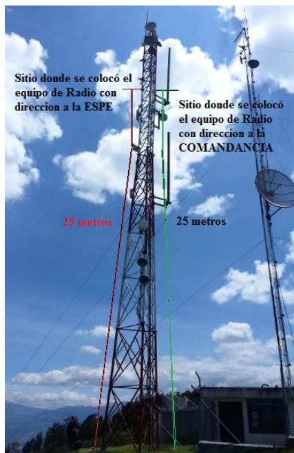
Figura. 4.3. Montaje de las antenas en Miravalle
