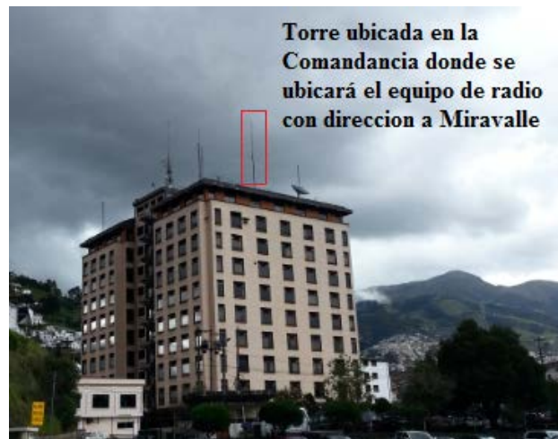
Figura. 4.4. Torre en la Comandancia donde se instalará el equipo de radio
