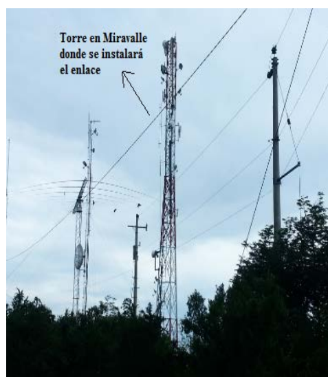
Figura. 4.2. Torre en Miravalle donde se colocará el equipo de radio
