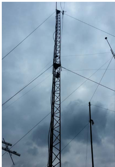
Figura. 2.25. Torre de telecomunicaciones ubicada en la Comandancia
