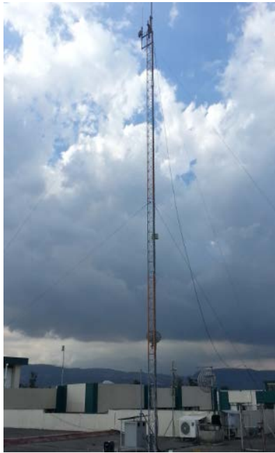
Figura. 3.36. Torre de telecomunicación ubicada en la Espe
