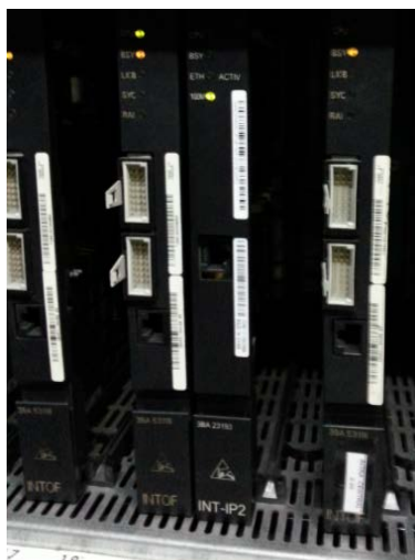
Figura. 3.12. Tarjetas INTOF para la distribución de las líneas telefónicas a los pisos del edificio
